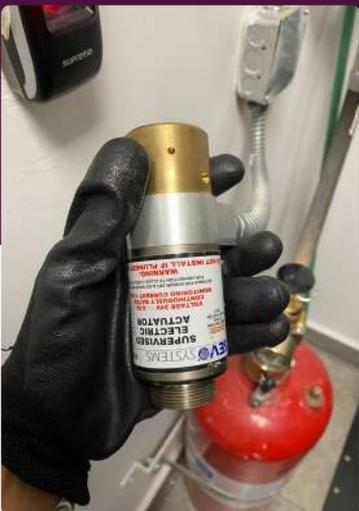
Durante la inspección se encontró que el problema era causado por un pin dañado ocasionando que el detector en ciertas ocasiones quede fuera de servicio y otro equipo se encontraba expuesto a una salida de ventilación originando falsas alarmas en el sistema.
